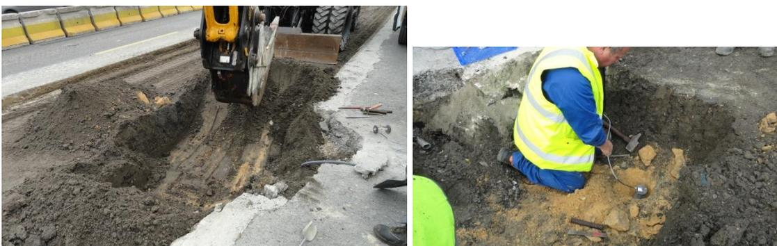
Figure 1.9. Mise en place des jauges de déformations verticales au sommet du sol support
