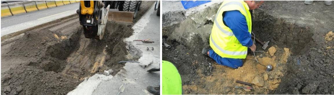
Figure 2.5. Mise en place des jauges verticales au sommet du sol
