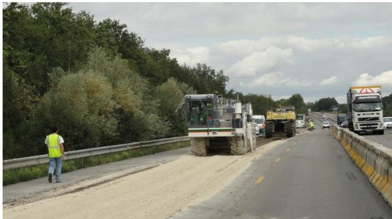
Figure 2.1. Retraitement en place au ciment de la couche de sable bitume, chantier de réhabilitation de la voie lente du tronc commun A10-A11 en 2011
