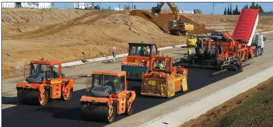
Figure 1.5 : Opérations de répandage (à droite de l’image) et de compactage (à gauche)
