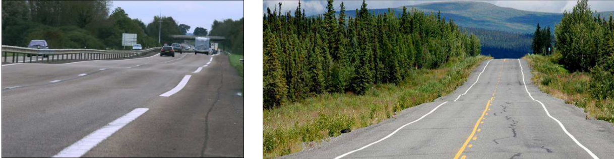
Figure 1.4 : Clichés de chaussées présentant des défauts d’uni longitudinal (ondulations)
